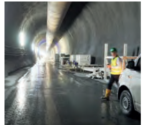
In zehn Jahren werden an dieser Stelle Züge mit bis zu 250 km/h vorbeifahren.
