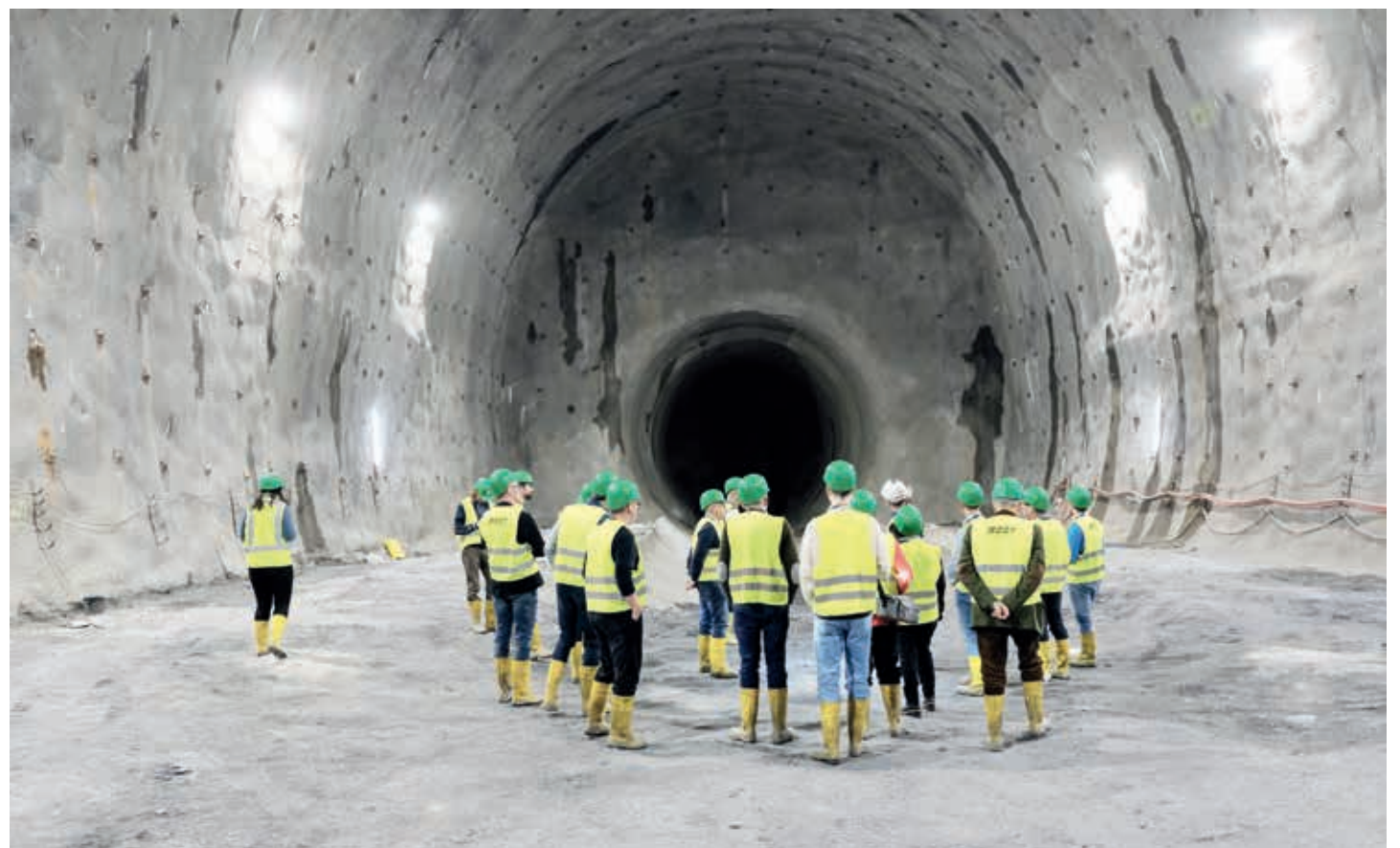
Blick ins schwarze Loch: Im Herbst wird in dieser Kaverne die Tunnelbaumaschine zusammgebaut, die sich anschließend Richtung Innsbruck bohren wird.
