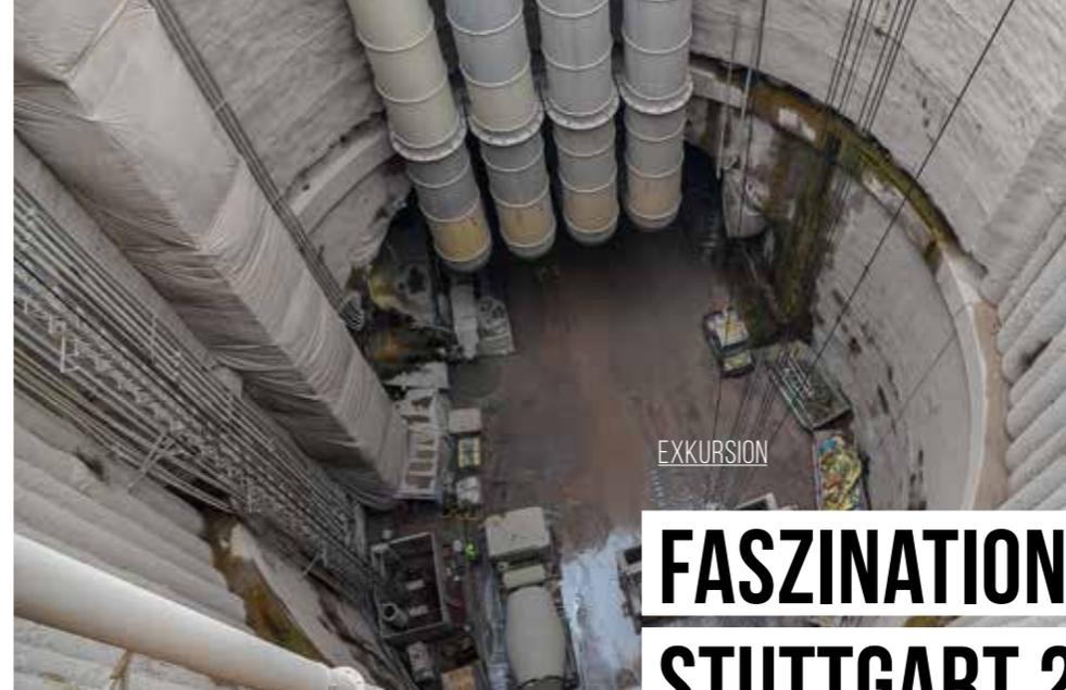
Blick in den 37 Meter tiefen und 22 Meter messenden Schacht im Zentrum Stuttgarts. Hier werden die Material- und Aushubtransporte des Zwischenangriffs Ulmer Straße abgefertigt.
